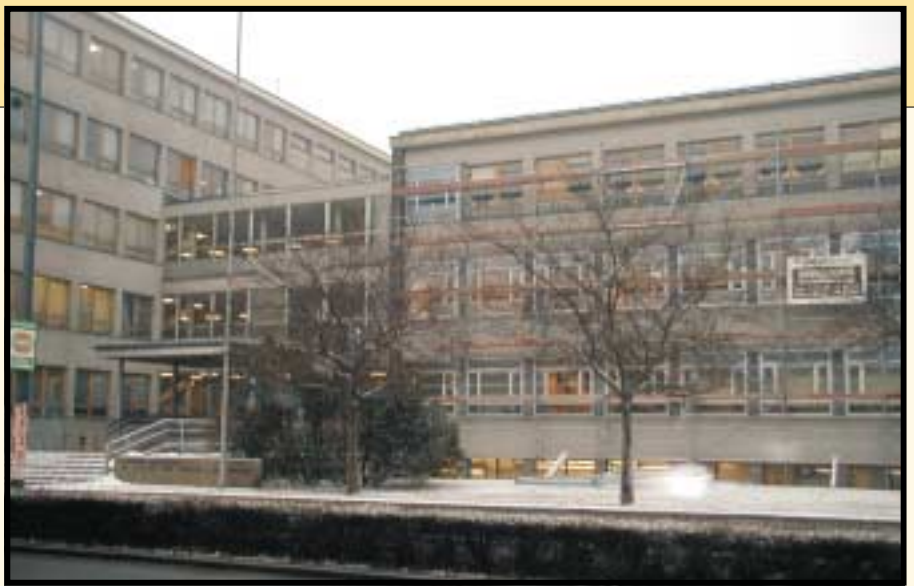
Die Graphische in Wien Ende Jänner – Neue Fenster für den Klassentrakt nachdem die Scheiben bereits aus den Rahmen fielen. Das ganze Gebäude soll demnächst großzügig umgebaut werden.
