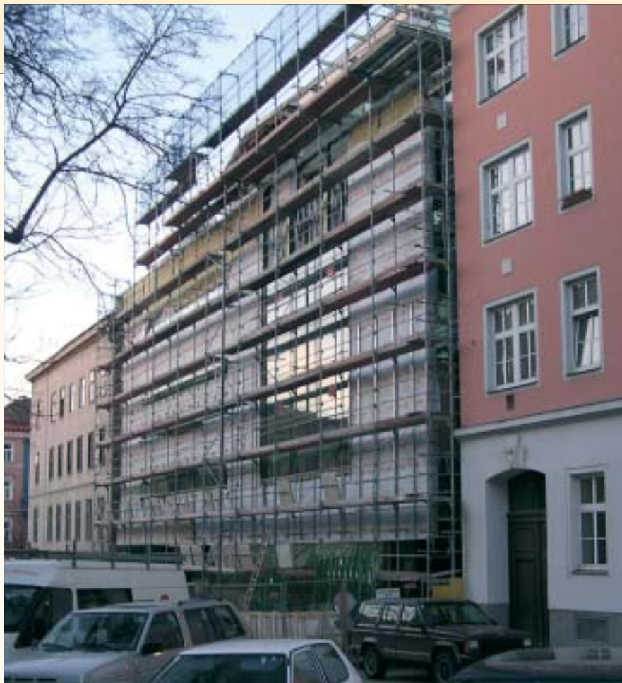
Das neue Reprozwolf-Haus in der Fockygasse zwei Monate vor Fertigstellung
